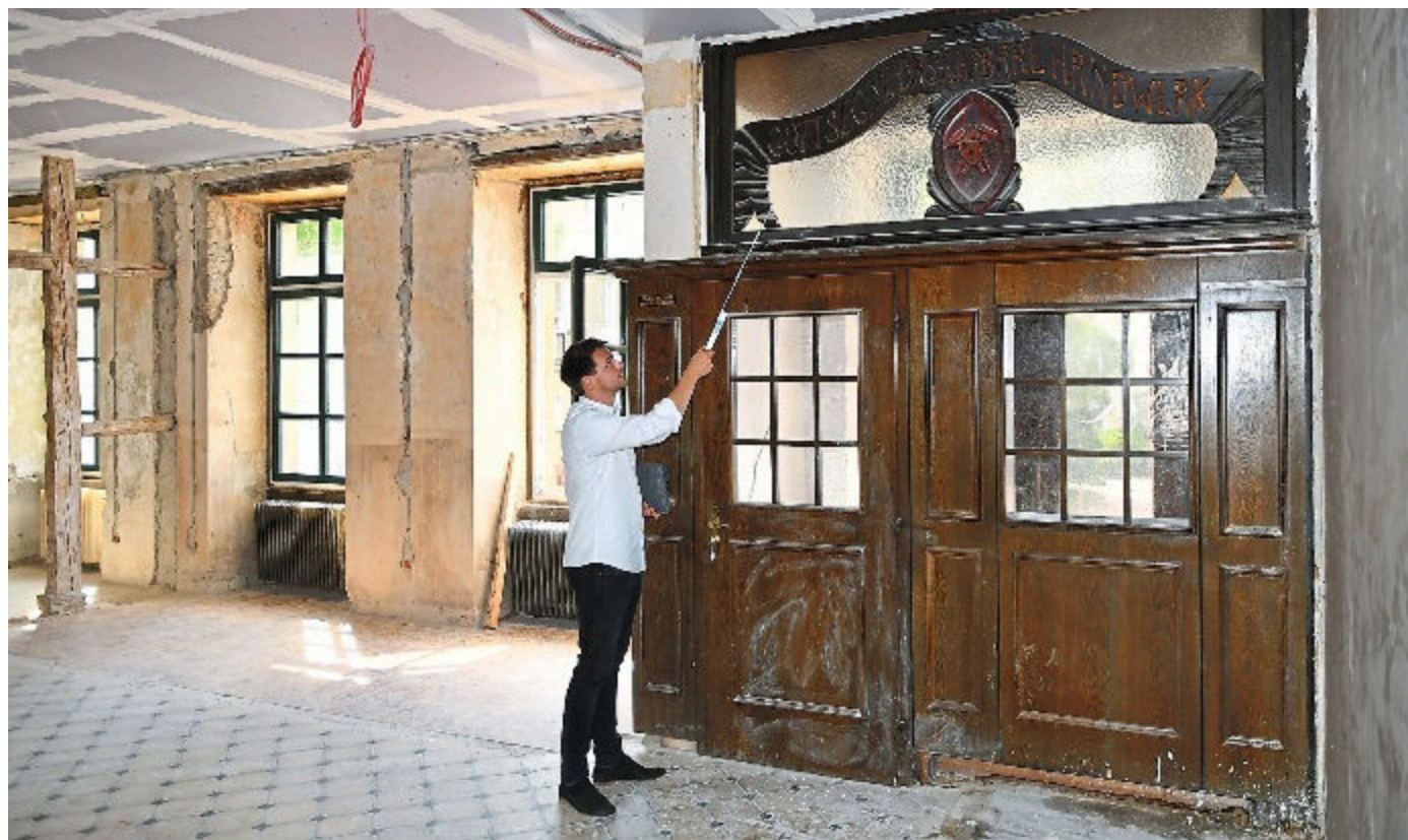
Der ehemalige Gastraum ist bereits entkernt. Der hölzerne Eingangsbereich, erklärt Simon Feldhaus, wird erhalten bleiben.
