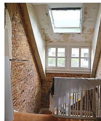
Im Treppenhaus ist der Mauerstein freigelegt.
